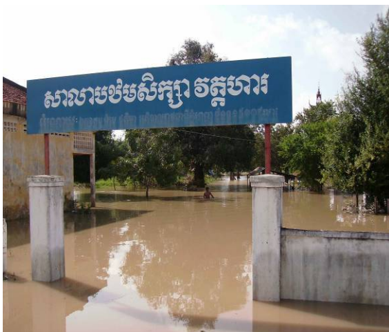
最も浸水被害を受けたワットハー小学校
