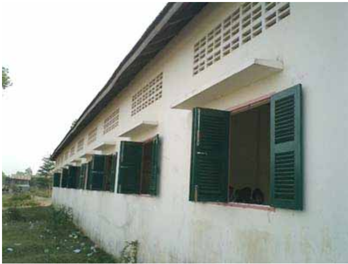
校舎の外から見た窓
